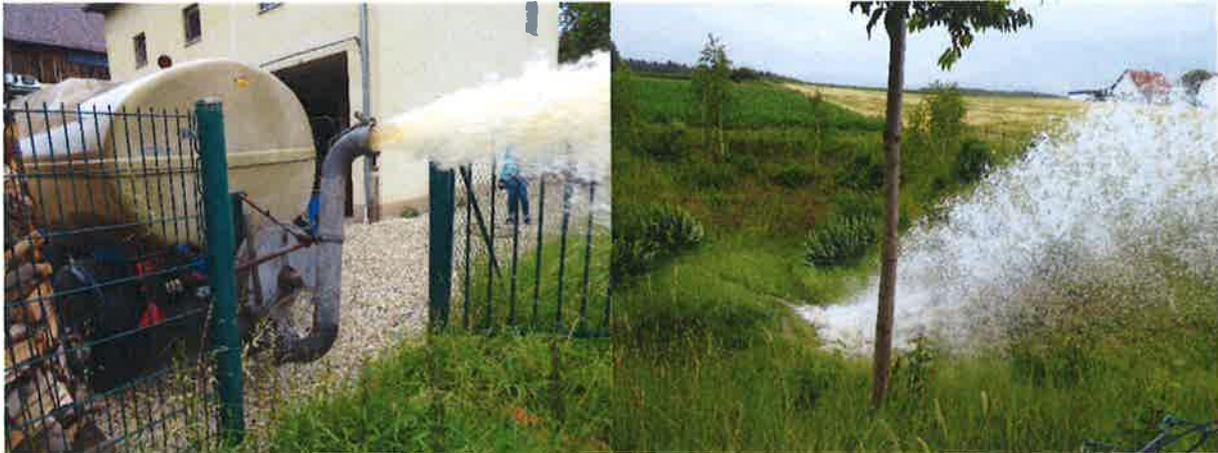
**Abbildung 2:** Entleerung des Tankwagens in das Sickerbecken 1
