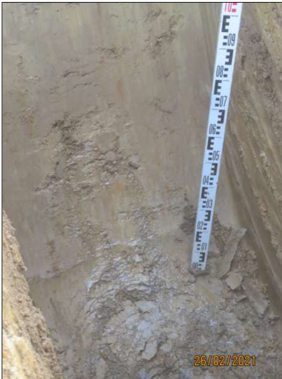
Bild-Nr. 20: Detail von Sch 5 mit Schichten-/ Sickerwasserzutritt ab 1,5 m u. GOK.
