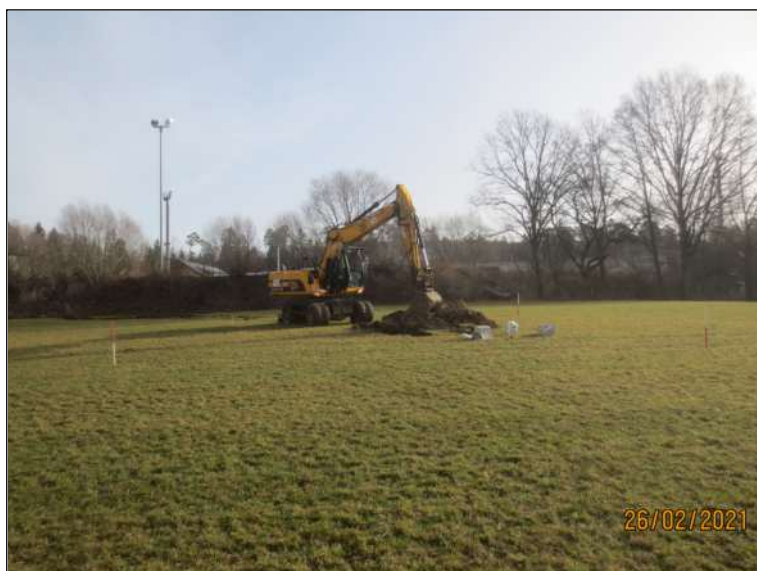
Bild-Nr. 15: Baggerschurf Sch 4. Blickrichtung Nordosten.
