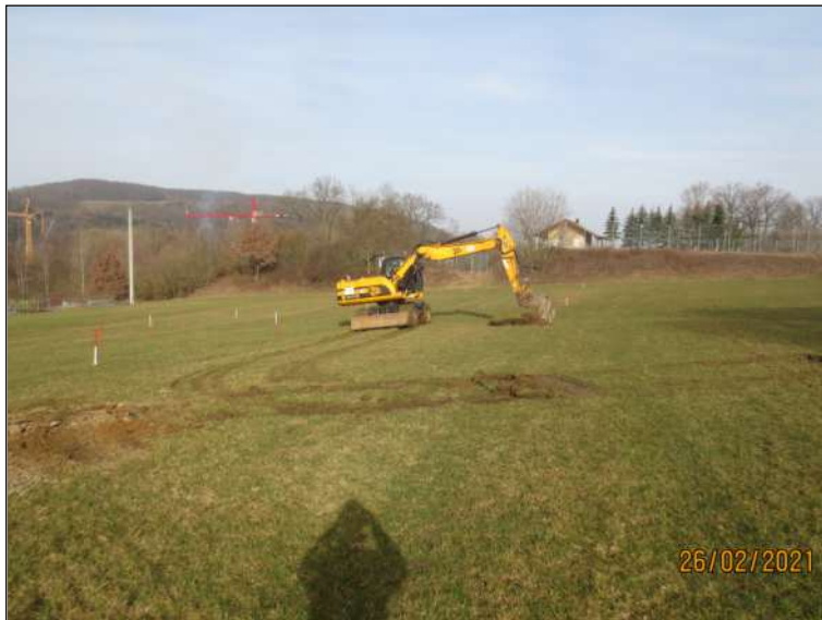
Bild-Nr. 18: Baggerschurf Sch 5. Blickrichtung Nordwesten.
