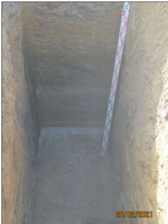
Bild-Nr. 10: Detail von Sch 1 mit Schichten-/ Sickerwasserzutritt ab 1,5 m u. GOK.
