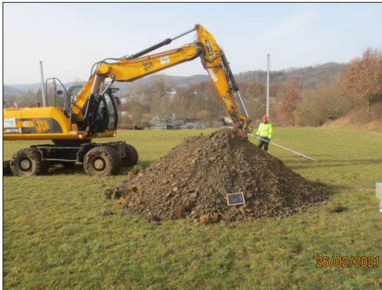
Bild-Nr. 8: Baggerschurf Sch 1. Blickrichtung Südwesten.
