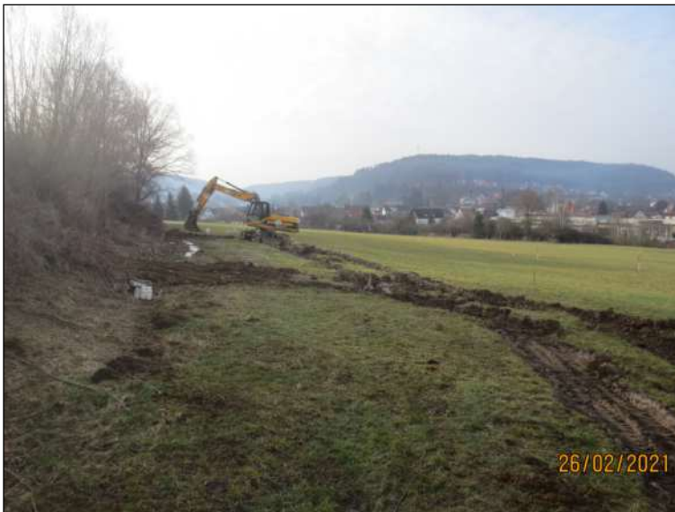
Bild-Nr. 4: Blick auf den geplanten Drainagegraben. Blickrichtung Südwesten.
